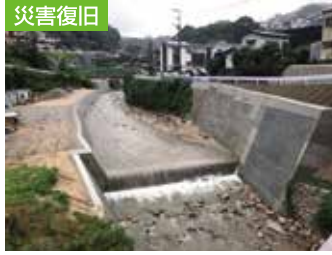
上温品4丁目(府中大川) 第2東山橋
