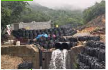
建設中の砂防ダム
