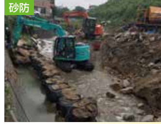
馬木2丁目(大谷川) 工事着手
